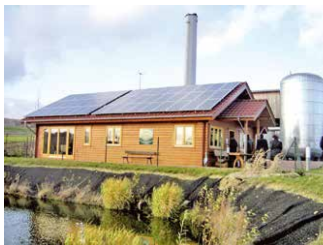
Рис. 4. Геліопанелі на дахах виробничих приміщень біоенергетичного селища Юнде
